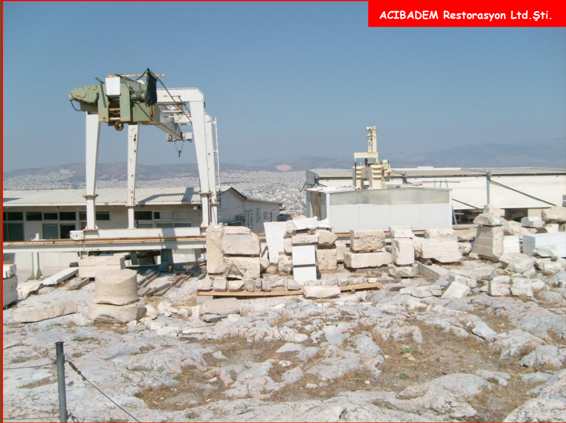
Fotoğraf 5 – Hassas Kesim Yapabilen Mermer Atölyesi (Akropolis içinde kurulu)
