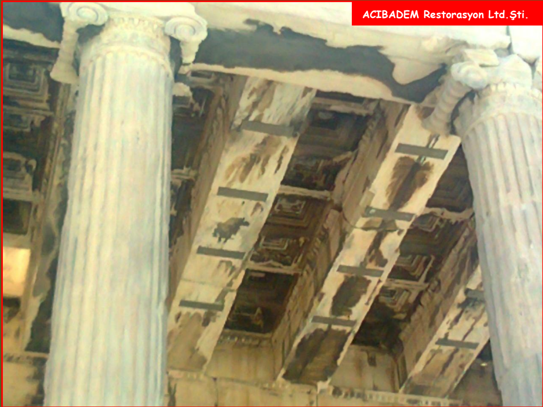
Fotoğraf 15 – Erechtheum Kuzey Cephesinde Kirişlerde Eğilme Dayanımı Arttırma Amaçlı Tamirler-B
