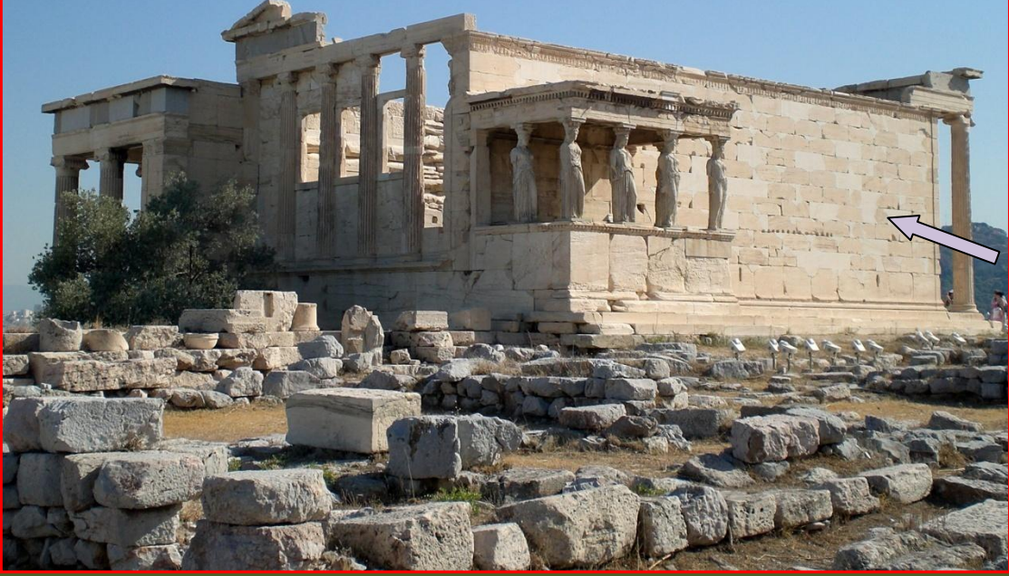
Fotoğraf 12 – Erechtheum Güney Cephede Taş Yenilemeleri (Bakış Yönü: Kuzey-Doğu)
