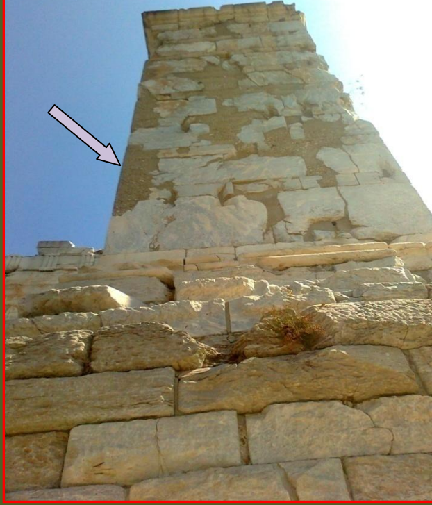
Fotoğraf 8 – Kuzey-Batı Kapı Kulesi (Beton-Harç ile tamir)
