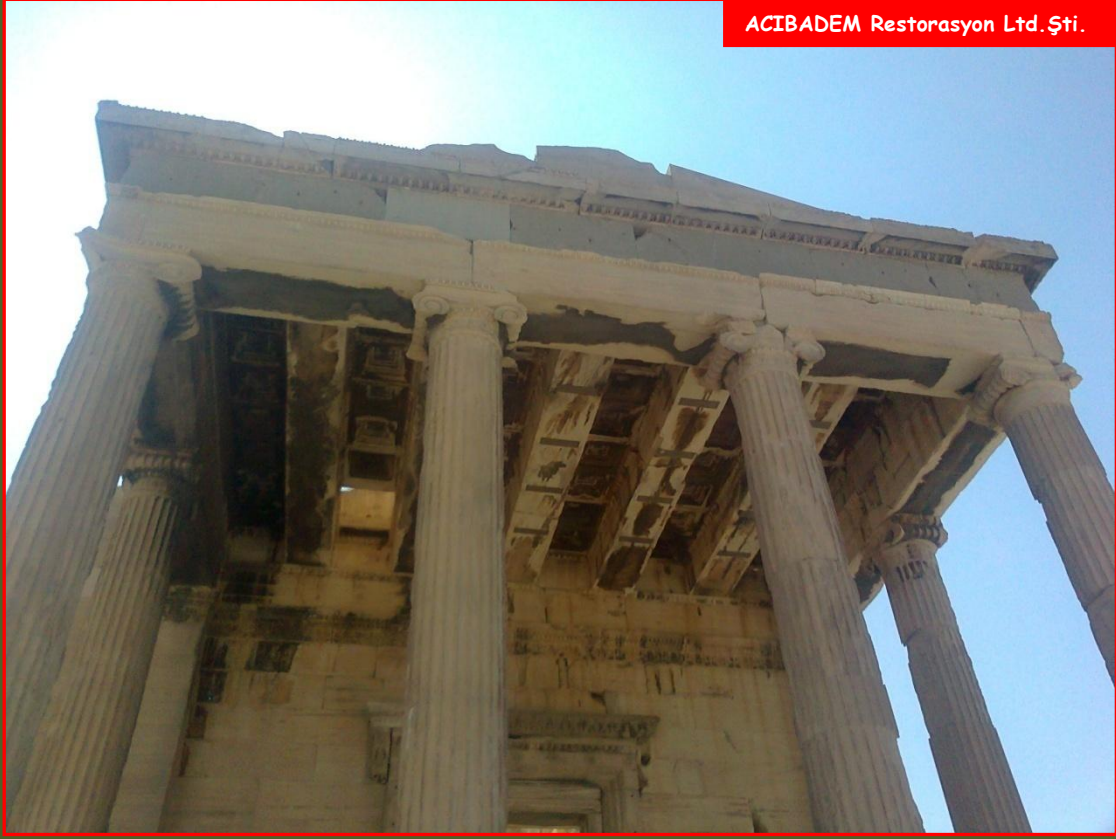
Fotoğraf 14 – Erechtheum Kuzey Cephesinde Kirişlerde Eğilme Dayanımı Arttırma Amaçlı Tamirler-A
